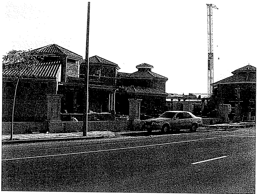
Sede Social en plena construcción
